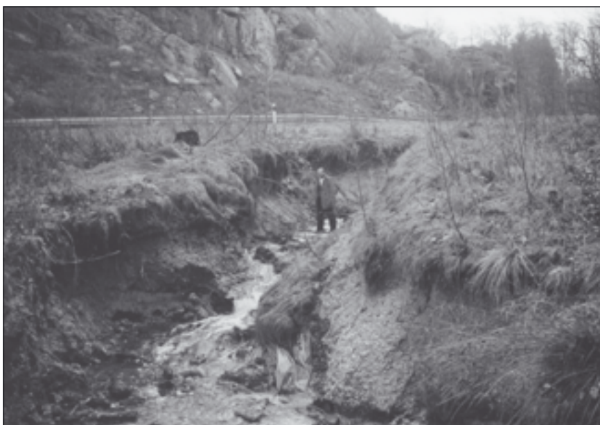
Fig. 88. Efter de stora skyfallen på Orust drabbades även Huseby klev. På bilden står författaren i den nya fåra som bäcken hade eroderat fram efter de stora regnen. Foto: Robert Hernek.
